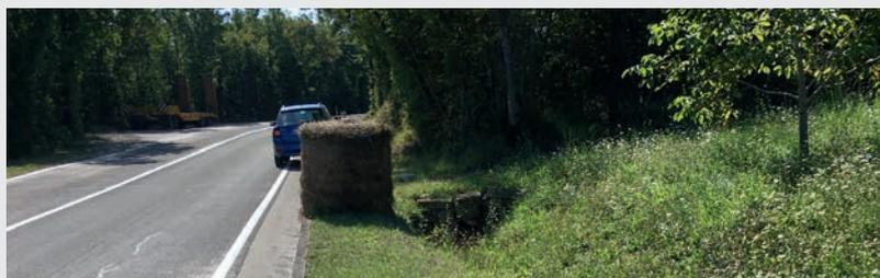
Système d'évacuation en béton non protégé
